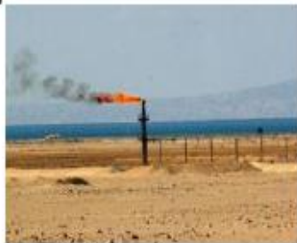
Črpališče surove nafte
