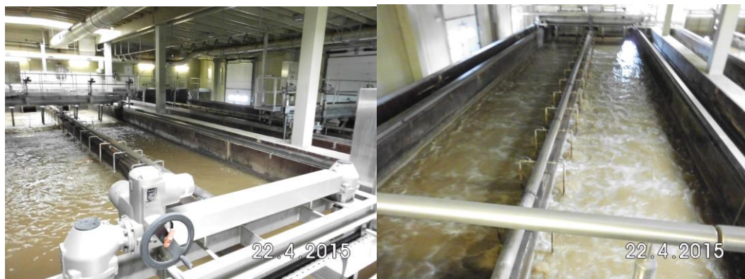
Slika 33: Ozračeni lovilce maščob in peskolov Vir: Lasten
