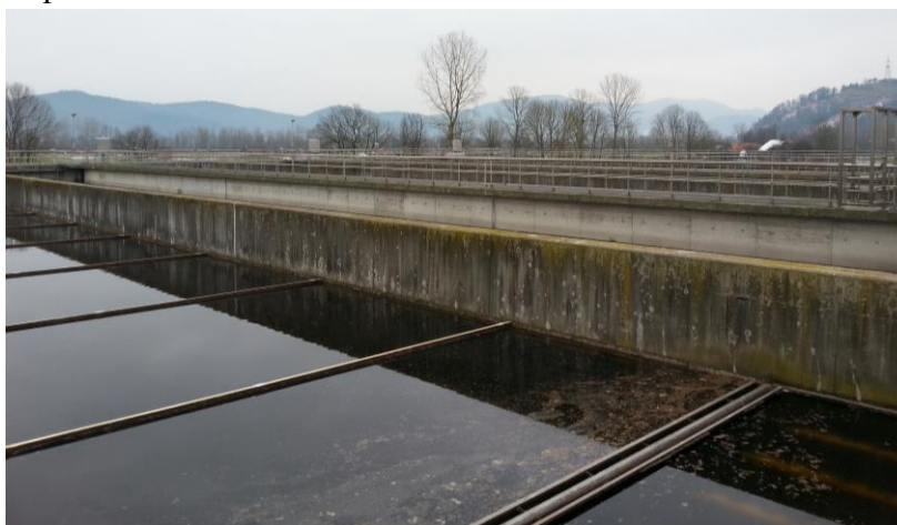
Slika 69: Naknadni usedalnik – 2. del biološkega čiščenja Vir: Lasten
