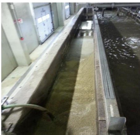
Slika 66: Kineta za odstranjevanje masti in olj iz odpadne vode
