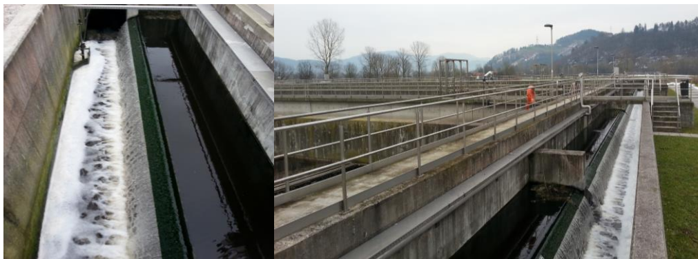
Slika 70: Izток prečiščene odpadne vode iz naknadnega usedalnika
