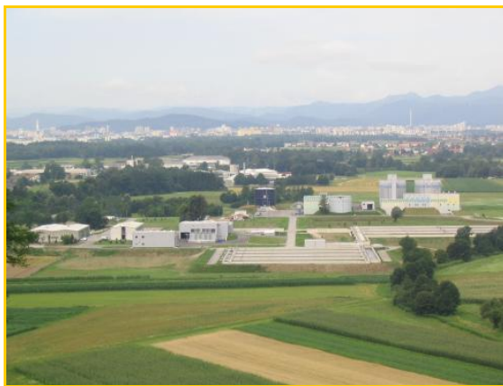
Slika 73: Centralna čistilna naprava Ljubljana
